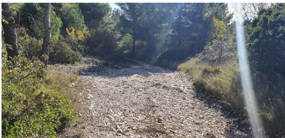
Slika 3. Oštećenje puta uslijed djelovanja vode
